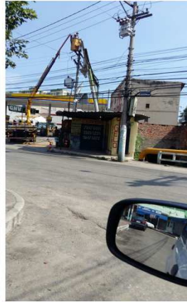
Outdoor caiu devido ao vento
